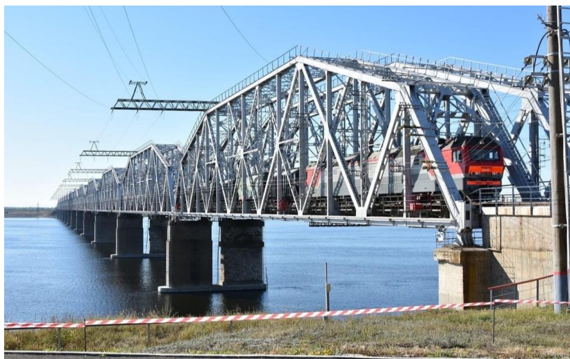
Рисунок 2 – Современный электрифицированный мост
