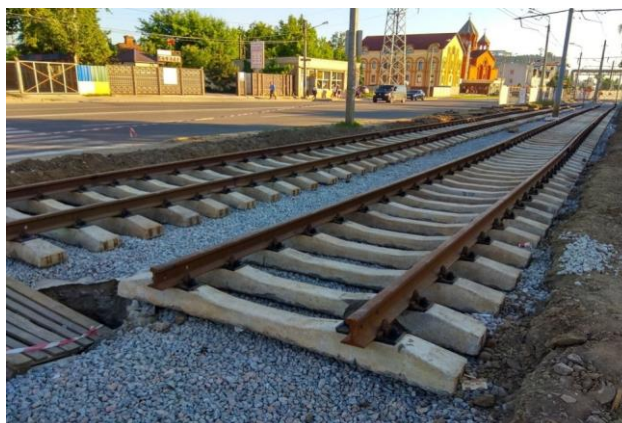
Рисунок 2 – Процесс замены деревянной шпальной решетки на железобетонную
