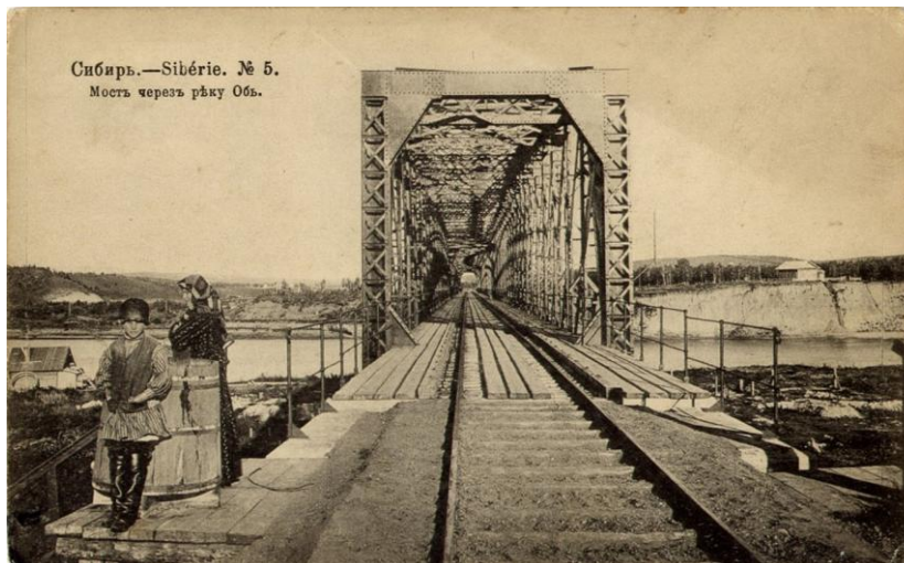
Рисунок 1 – Старый арочный мост
