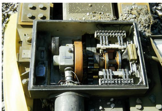
Рисунок 2 – Стрелочный электропривод
