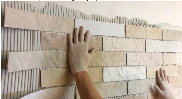
Рисунок 1 – Укладка гибкой плитки
