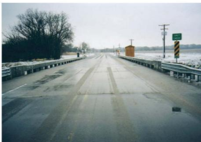
Рисунок 1 – Мост Рока-Спур. Отсутствие скопления льда и снега во время первой метели, апрель 2003 г.
