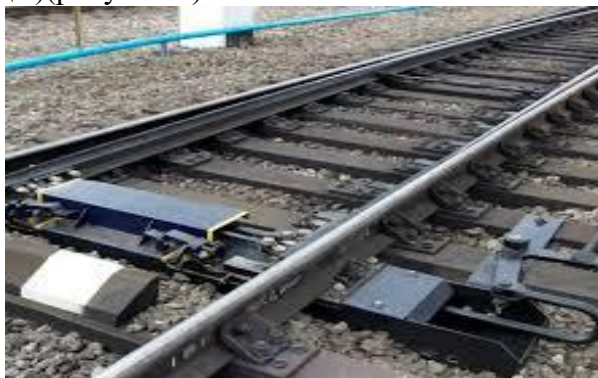
Рисунок 1 – Электромеханический привод УПС для стрелочного перевода
